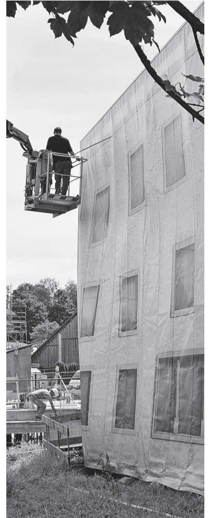
Aus luftiger Höhe wurde die Blache über zwei Aussenwände gespannt.
