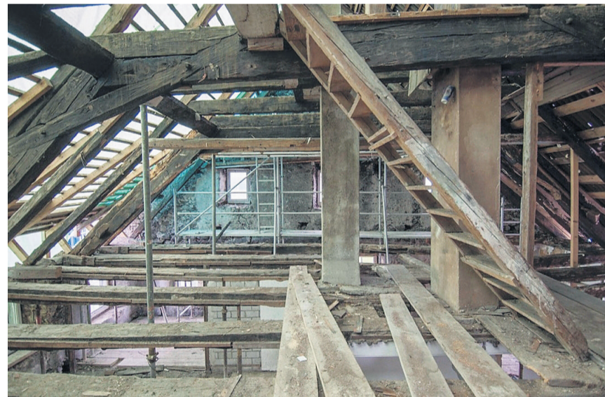
Imposanter Dachstuhl: Dieser wird demnächst abgebaut.
