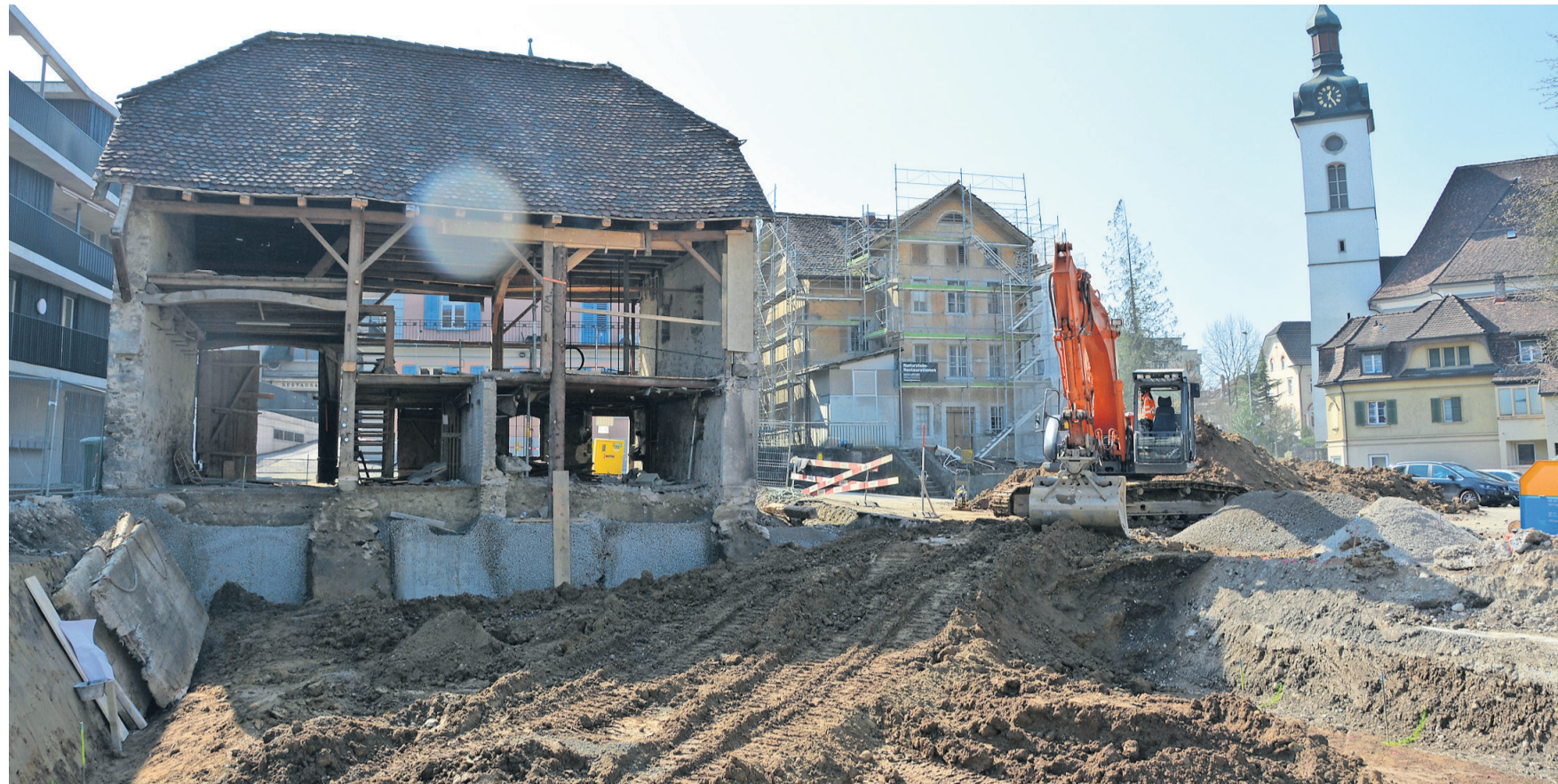
Die umfangreichen Bauarbeiten an ibw-Schüür (links) und Geissmannhaus (Mitte) sind im Gang; Rechts ist der alte ibw-Platz, der bald die lang ersehnte Neugestaltung erhalten soll.
