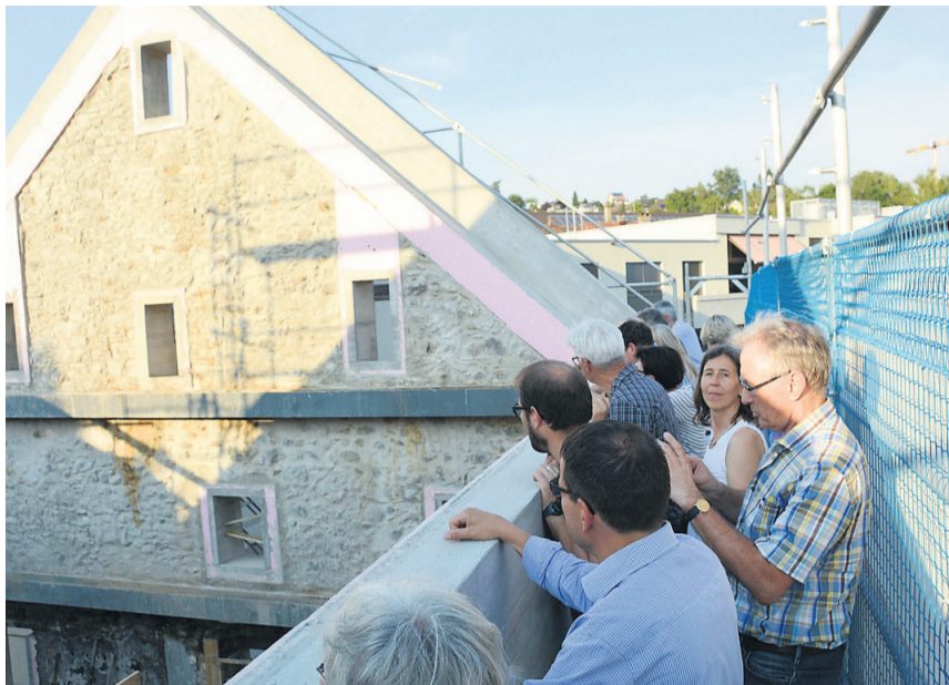
Das Haus ist ausgehöhlt und die Grundmauern stehen noch: Von oben ergibt sich nun ein informativer Einblick ins künftige Kulturhaus Schlössli.
