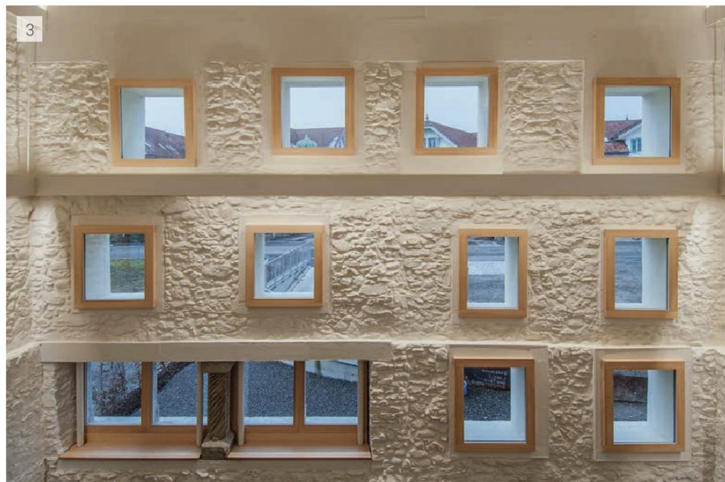
3 Dachkranz und neue Fenstergewände sind aus Ortbeton, Aussteifungen in Form von Stahlträgern nehmen zudem die indirekte Beleuchtung auf.
